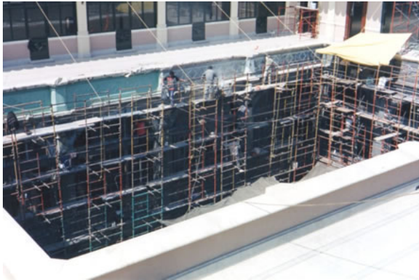
Trabajos en el interior del Palacio
