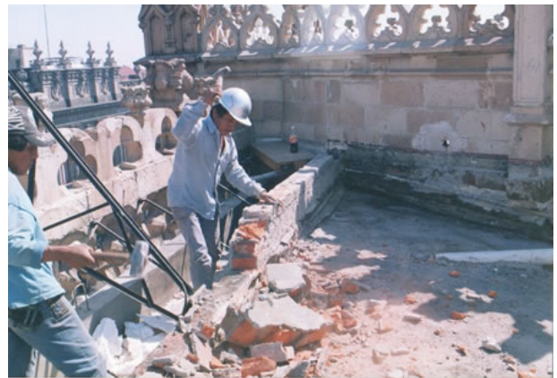
Demolición de construcción agregada
