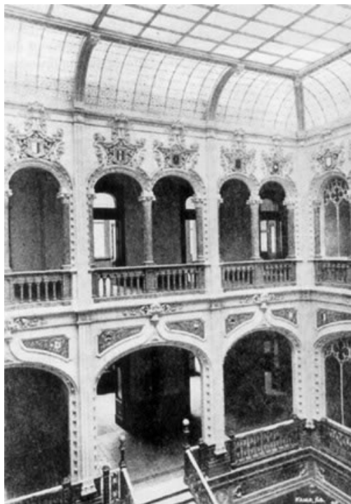
Interior del palacio Postal
