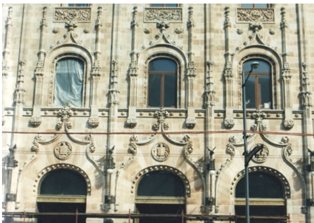
Restauración de fachadas
