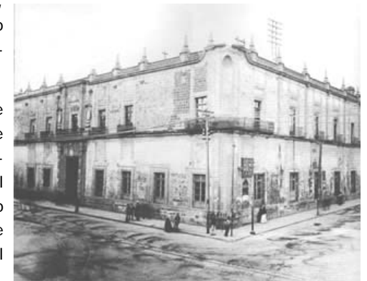
Antiguo Hospital de Terceros
