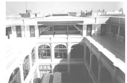
Niveles superiores restaurados
