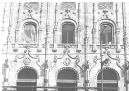
Restauración de fachadas
