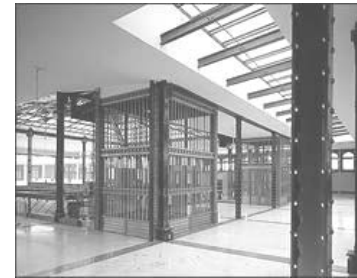
Cuarto nivel concluido
