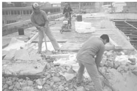
Reparación en azotea
