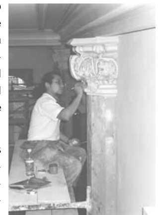
Restauración de columnas
