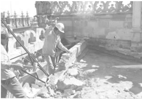
Demolición de construcción agregada
